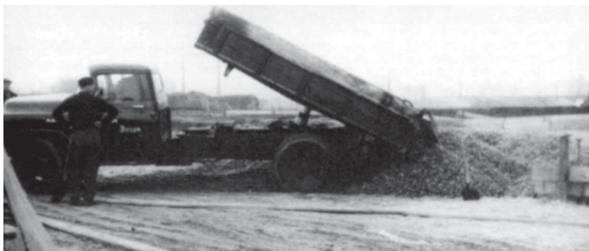
► Bouwactiviteiten: na de eerste steen kwamen al gauw de andere stenen in alle soorten en maten: de bouw nam een aanvang.
